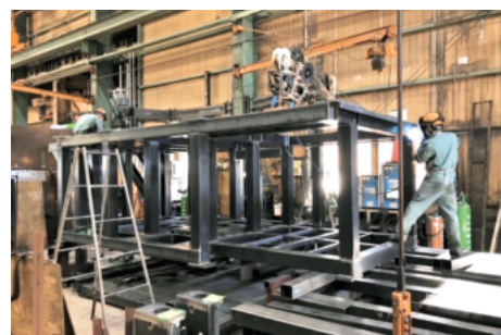
重量物の溶接
